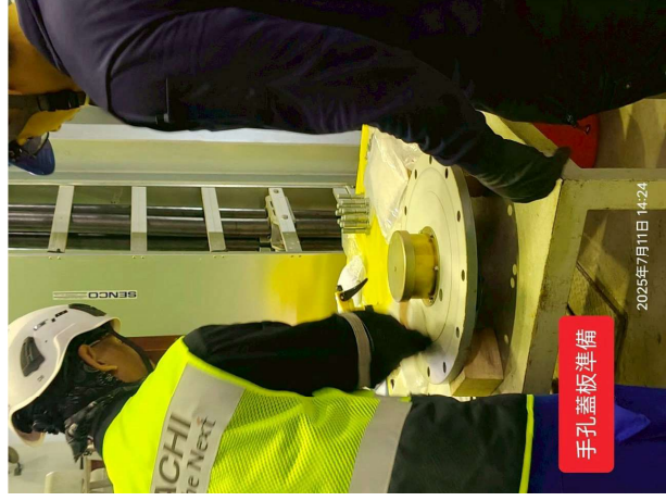
CH-2底部法蘭除鏽整理
